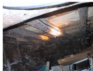
Source : CALL PACT Avant travaux
