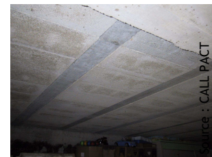
Source : CALL PACT Après travaux
