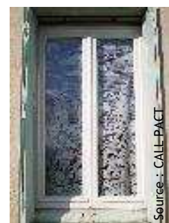
Source : CALL PACT Après travaux
