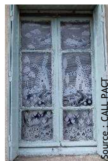
Source : CALL PACT Avant travaux
